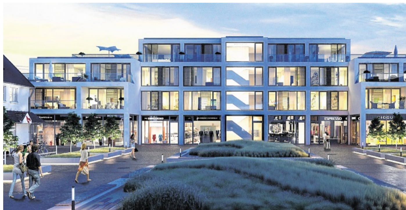
Auch im Gebäude nimmt die „Neue Mitte“ Gestalt an – die ersten beiden Einzelhändler haben ihre Geschäftsräume eröffnet. DC
